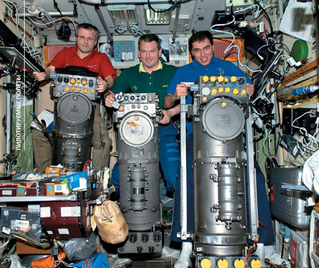
▲ Впервые на борту МКС целых три жидкостных блока системы «Электрон»! 7 июля космонавты проложили и смонтировали за панелями кабель для контроля температуры системы «Электрон-ВМ». 8 июля был заменен блок жидкостной (БЖ) «Электрона» (демонтаж – БЖ №056, монтаж – БЖ №011) – и система заработала
