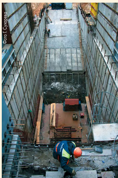
▲ Облицовка газохода стартового комплекса «Ангара» в Плесецке должна быть закончена в конце июня 2008 г.
