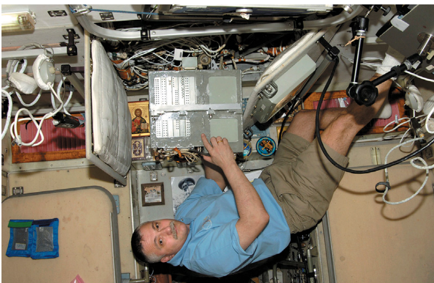
▲ Федор Юрчихин занимается ремонтом телеметрической системы в Служебном модуле
