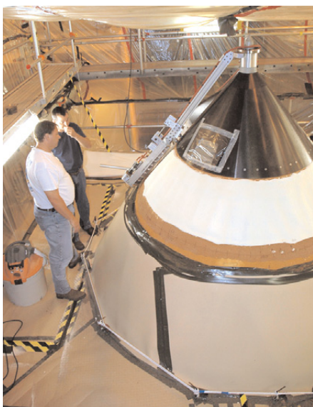
▲ Вверху — так выглядел внешний бак перед самым стартом. Внизу — ремонт теплоизоляции с помощью «точилки для карандаша»
