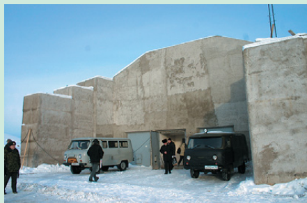
▲ Сооружение № 3. Командный пункт
