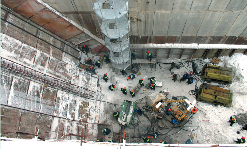
▲ Бурение шурфов и заливка их бетоном в газоотводном лотке
