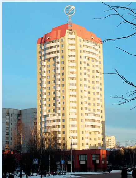
▲ Жилой дом в Королеве, построенный РКК «Энергия»
