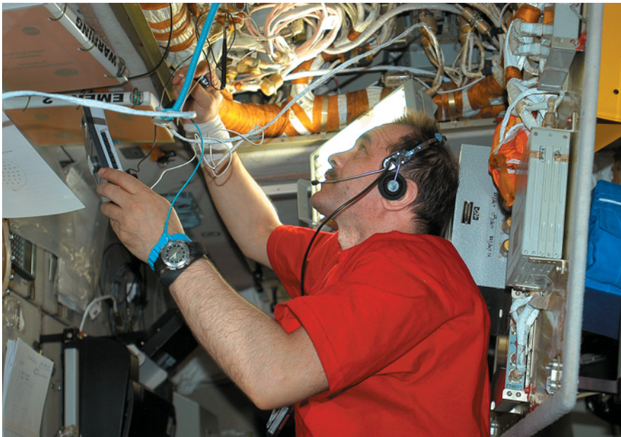
▲ Павел Виноградов что-то ремонтирует за панелью в «Пирсе»
