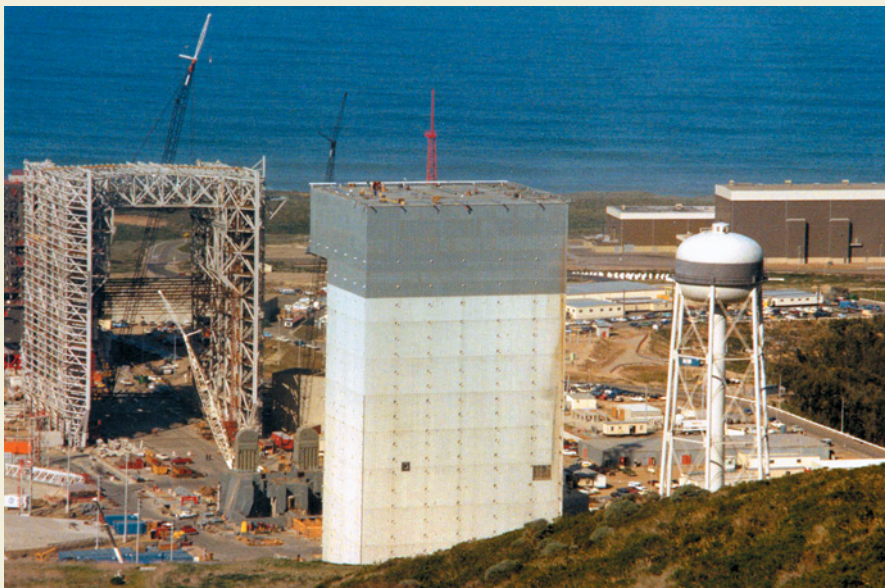
▲ Строительство стартового комплекса SLC-6 для шаттлов на базе Ванденберг
