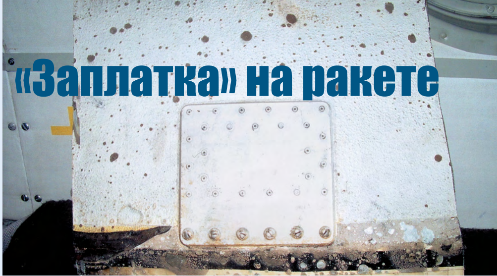
▲ Отремонтированный фрагмент головного обтекателя РН «Союз-ФГ»
