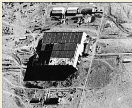
Строительство МИКа носителя Н-1 на площадке 112А. Конец 1966 г.
