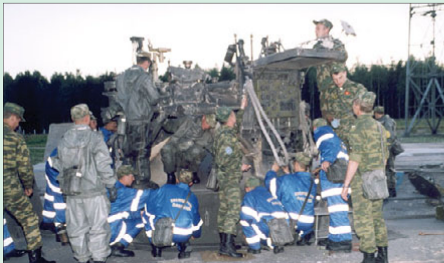
Работы по демонтажу одноразовых элементов стартового комплекса
