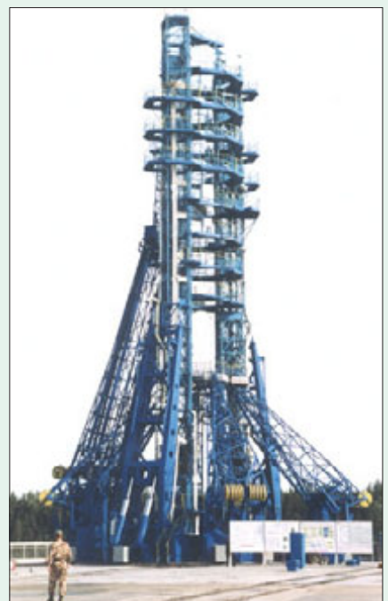
Стартовый комплекс РКК «Союз-2». Фермы обслуживания, переоборудованные под обтекатель большего диаметра
