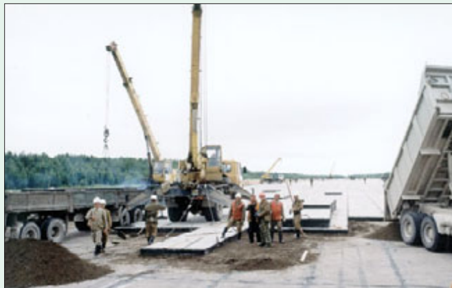
Реконструкцию ведут военнослужащие 119-го строительного управления МО
