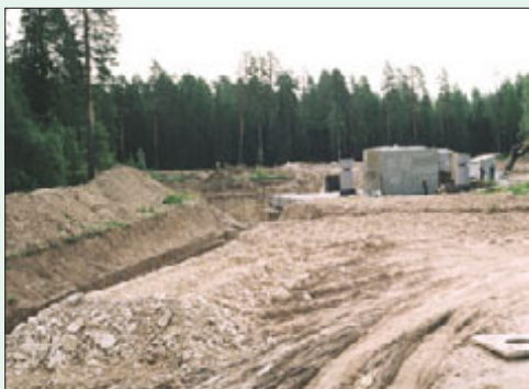
На площадке завершается прокладка новых коммуникаций
