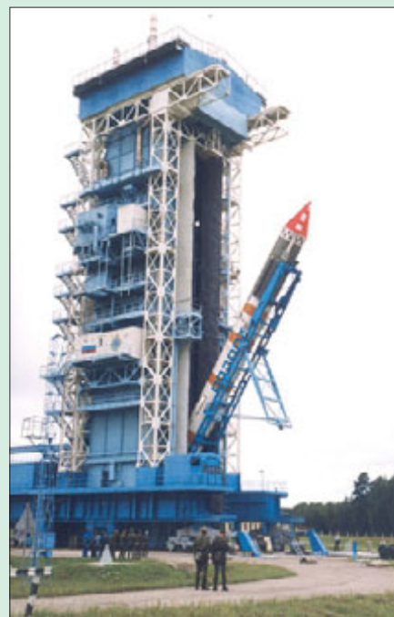
Подъем почти завершен
