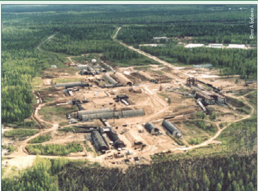
Строительство стартового комплекса для РКК «Ангара-5»
