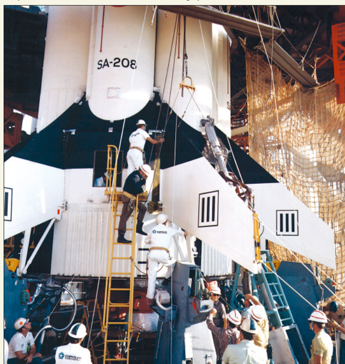
Замена стабилизаторов на РН «Сатурн-1В»
