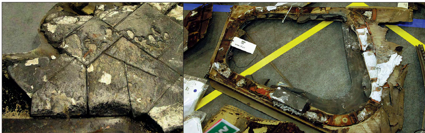
Теплозащитное покрытие нижней стороны левого крыла
