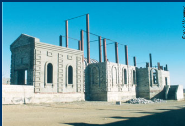
Строительство православной церкви в городе
