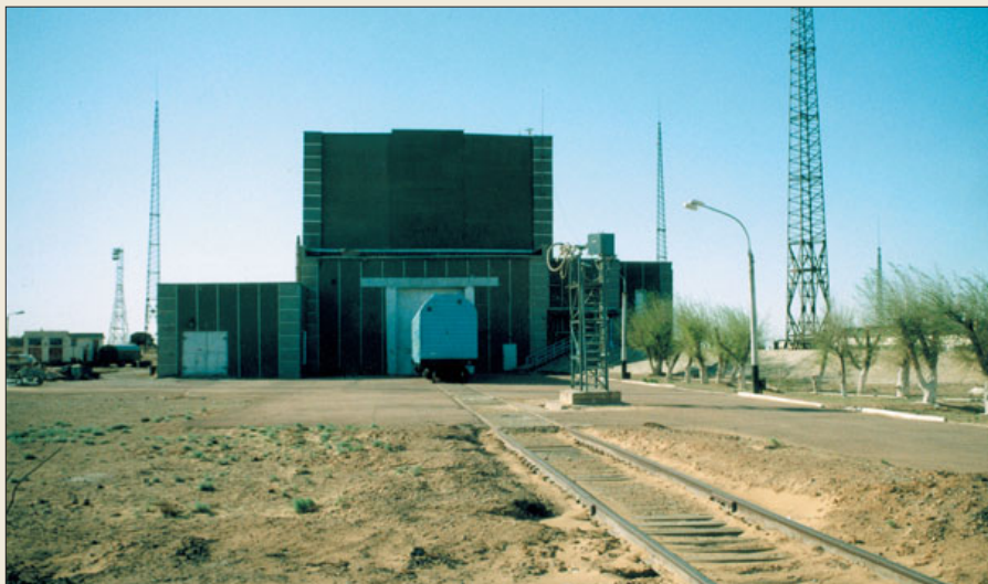
Заправочная станция 11Г12 на площадке 32 космодрома Байконур
