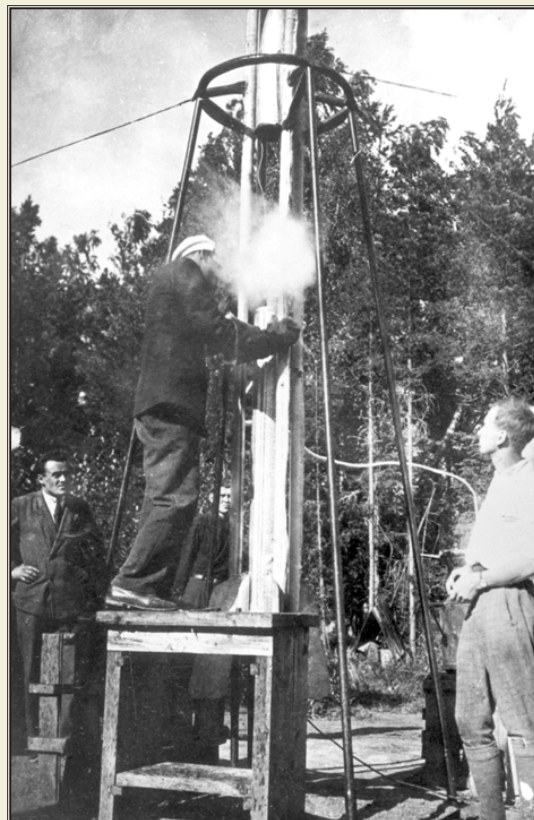
Заправка жидким кислородом первой советской жидкостной ракеты ГИРД Р-1 (объект 09). 13 августа 1933 г.
