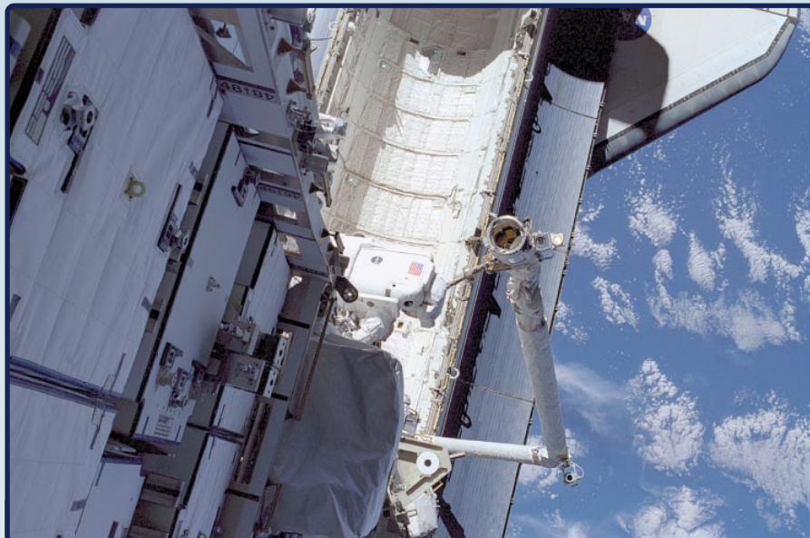
Первый выход – монтаж фермы к платформе Z1
