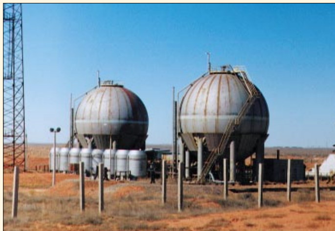
Для обеспечения пуска РН «Зенит» был создан запас жидкого кислорода массой более 900 тонн
