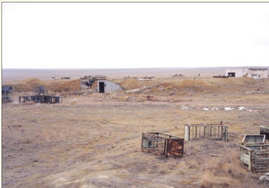
Подземный командный пункт на площадке 161
