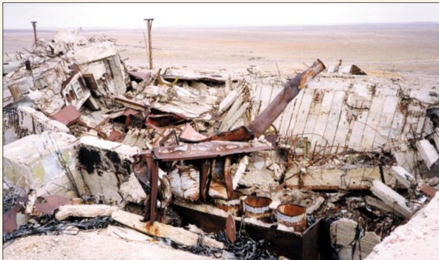
Остатки ШПУ на площадке 161
