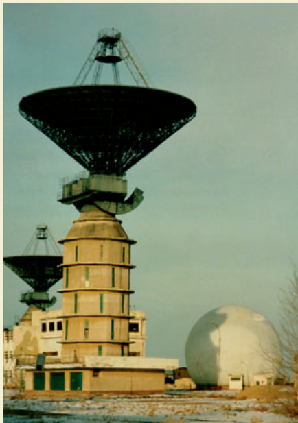
Один из символов Байконура – антенны П-200. Справа внизу «шарик» антенна КТНА – дубля КРЛ системы аварийного спасения
