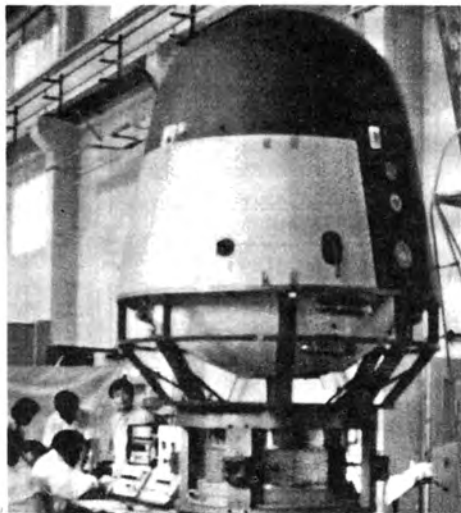
Фото СА с ТДУ на испытательном стенде. Из проспекта CAST.
