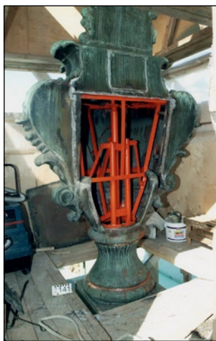
Выколотная скульптура на парапете Зимнего дворца. Через открытый каркас видно внутреннее устройство. Изготовлена на фабрике А. П. Морана. Конец XIX — начало XX века.
