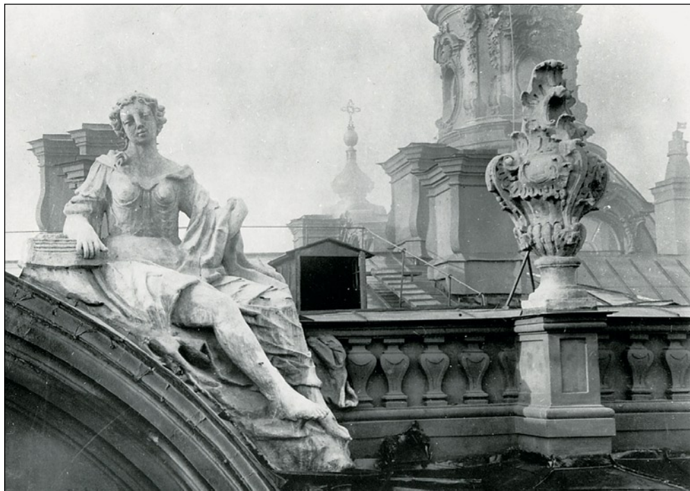
Выколотная скульптура на парапете Зимнего дворца. Через открытый каркас видно внутреннее устройство. Изготовлена на фабрике А. П. Морана. Конец XIX — начало XX века.
