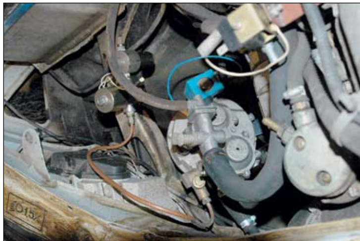
Редуктор-испаритель в пропановой системе требует подогрева. На фото хорошо виден шланг, соединяющий жидкостный теплообменник редуктора с системой охлаждения двигателя.
