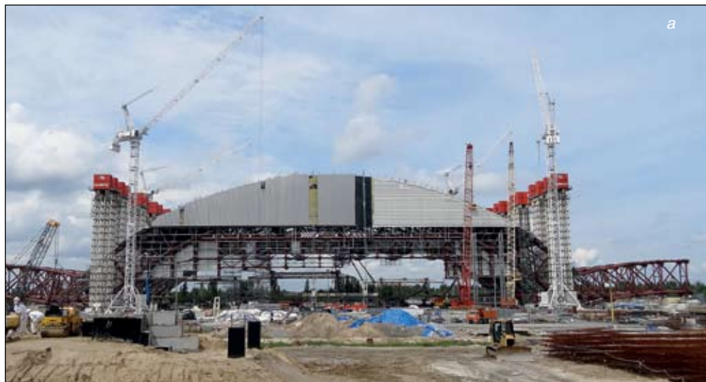
Монтаж арки (стадия перед вторым подъемом, июнь 2013 года): а — фасад со стороны саркофага; б — вид сбоку.
