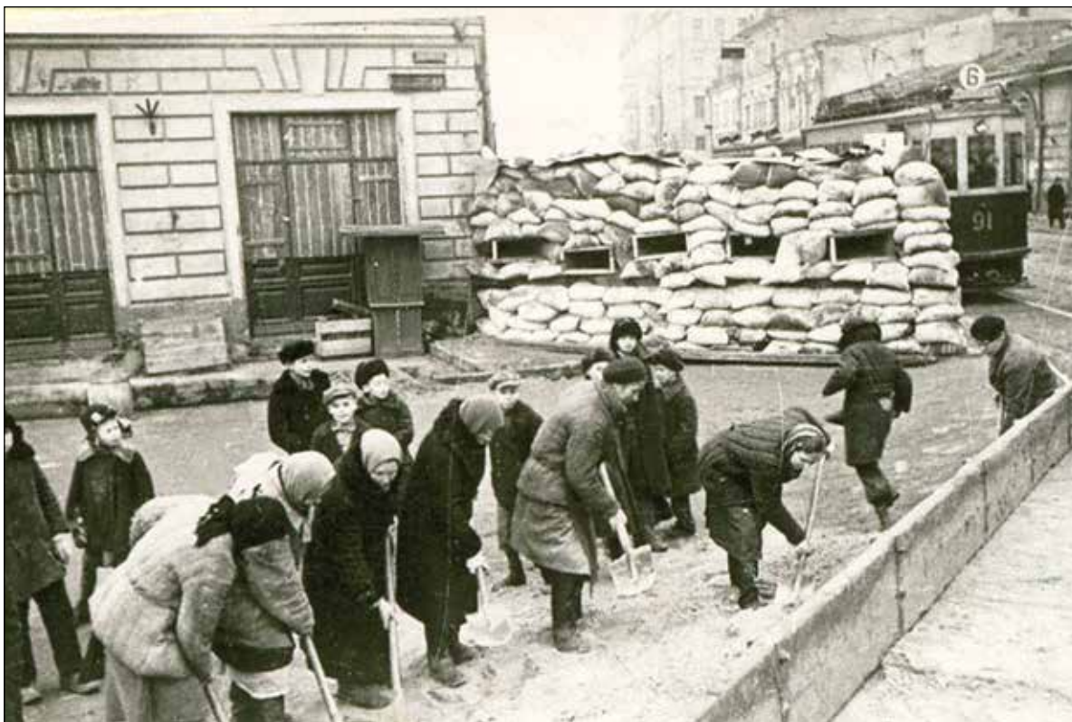
Строительство оборонительных сооружений на улицах Москвы. 1941 год
