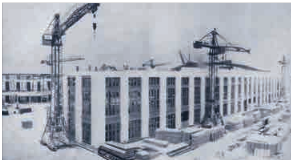
Строительство крытого спортзала
