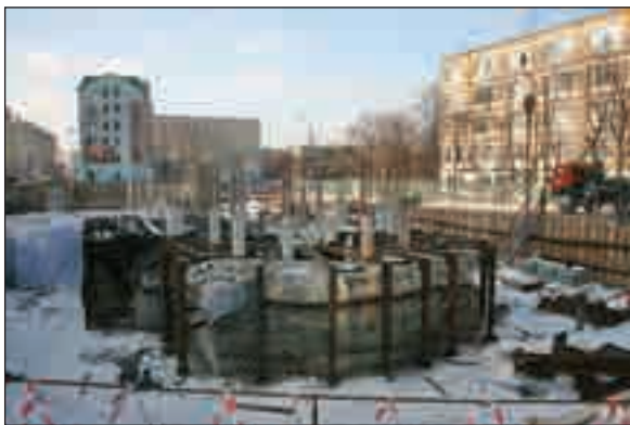
Исторические фундаменты во временном железобетонном защитном кожухе. 2013 год
