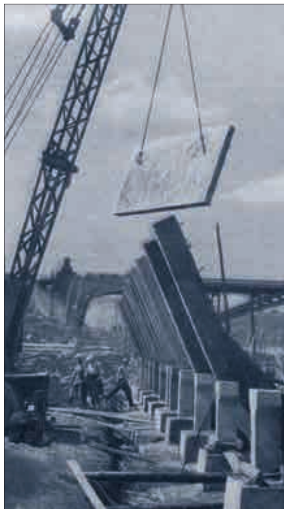
На строительстве Новодевичьей набережной. Монтаж сборной стенки
