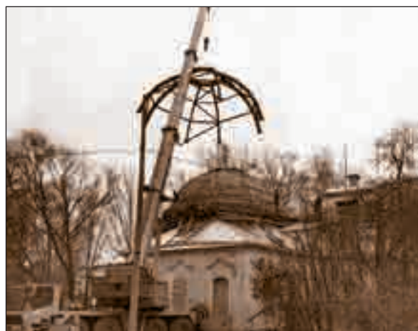
Установка каркаса купола
