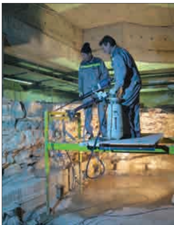
Работы по укреплению исторических фундаментов. 2015 год
