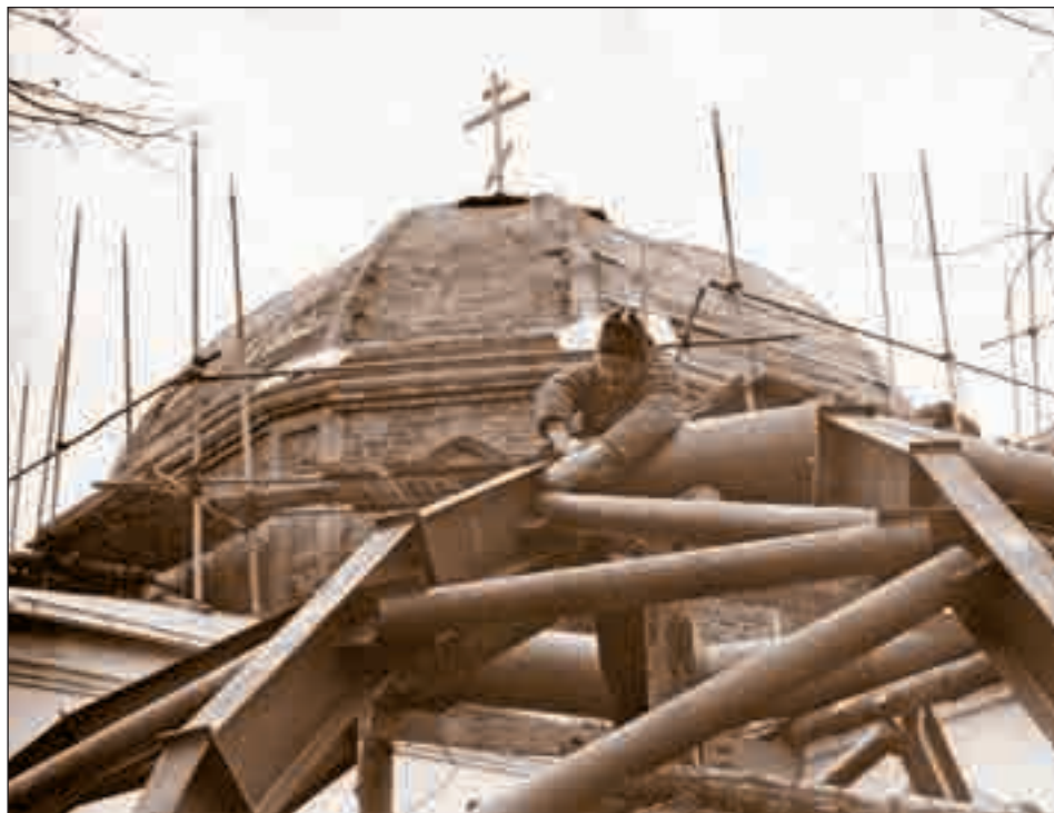
Установка каркаса купола
