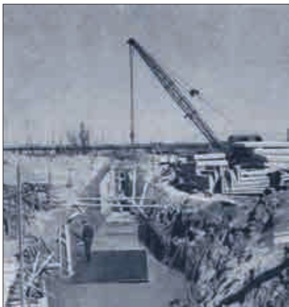
Строительство сборного железобетонного коллектора для подземных коммуникаций
