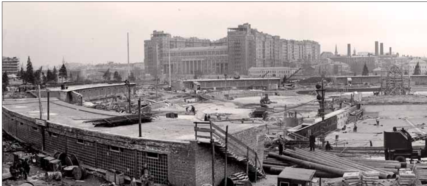
Строительство бассейна «Москва». 1960 год.
