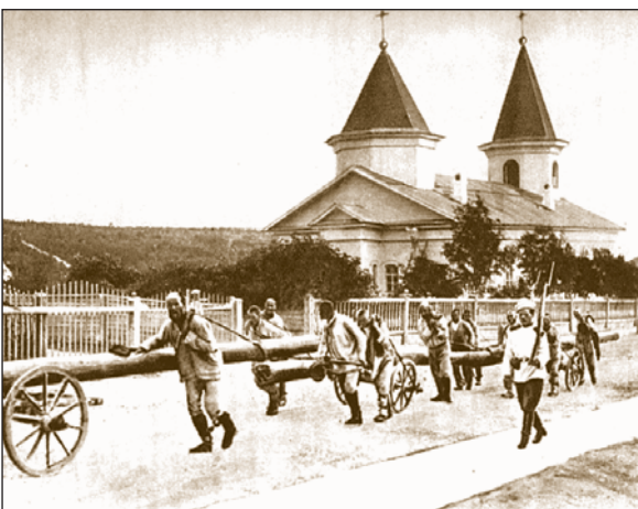
Арестанты на каторжных работах
