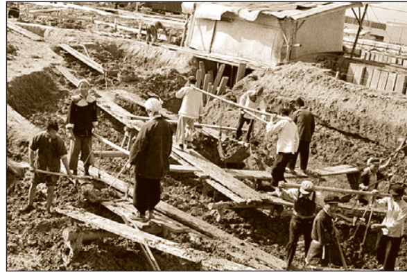
Земляные работы на одной из строек города Ханьдань. КНР. 1955—1956 годы. 0-84344
