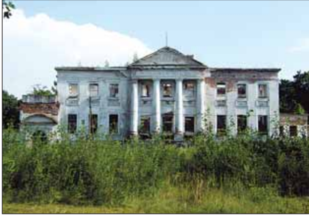
Северный фасад усадебного дома
