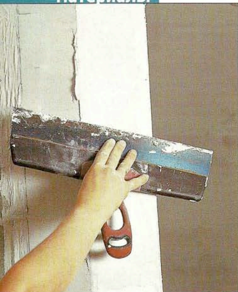
➡ Нанесение шпаклёвки на внешний угол с одной стороны...
