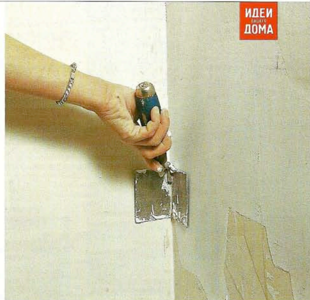
➔ Выравнивать внутренние углы удобно с помощью специального шпателя
