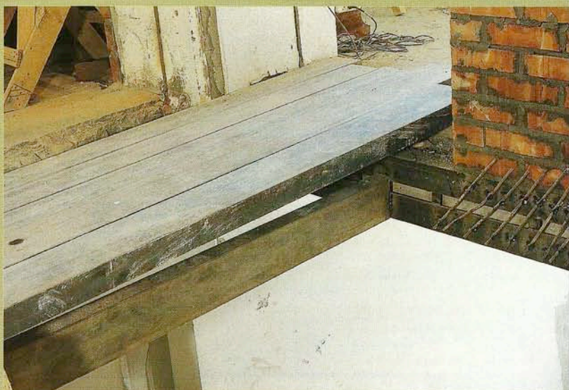
⦿ Верхний уровень. Межэтажный проём по периметру надёжно укреплён «солидной» стальной фермой. Приваренные железные прутья—арматура для последующего крепления несущей конструкции лестницы
