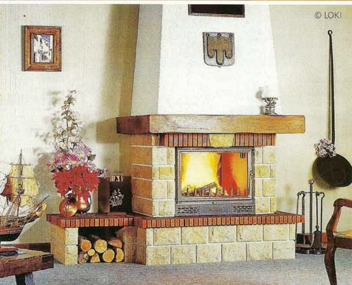
Популярный вариант конструкции камина со встроенной металлической топкой
