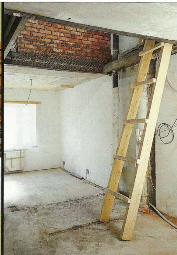
⦿ Верхний уровень. Межэтажный проём по периметру надёжно укреплён «солидной» стальной фермой. Приваренные железные прутья—арматура для последующего крепления несущей конструкции лестницы
