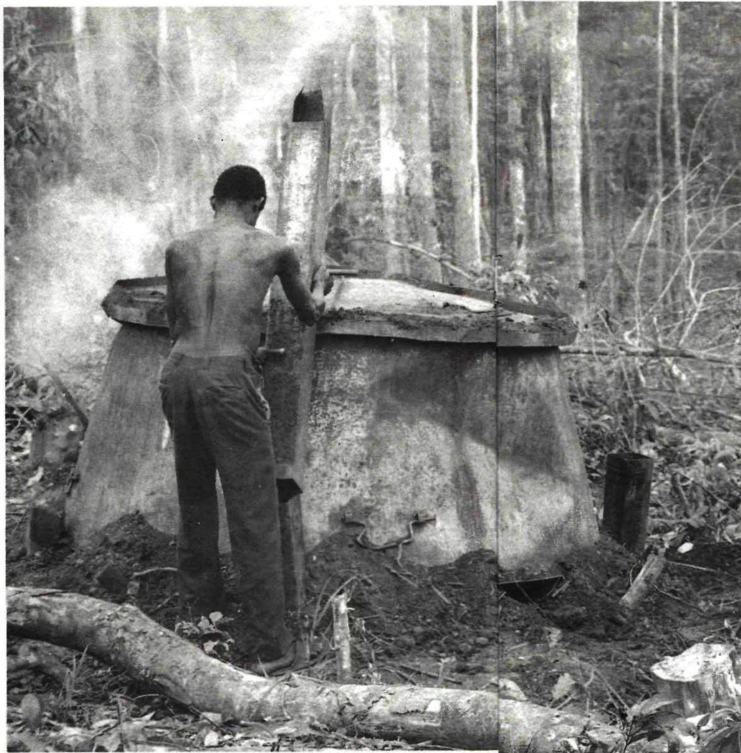
Сушильная печь для производства древесного угля в лесном заповеднике, расположенном в долине р. Субри в Гане. Для получения этого экономичного вида топлива используются древесные отходы, образовавшиеся при расчистке лесных земель.
