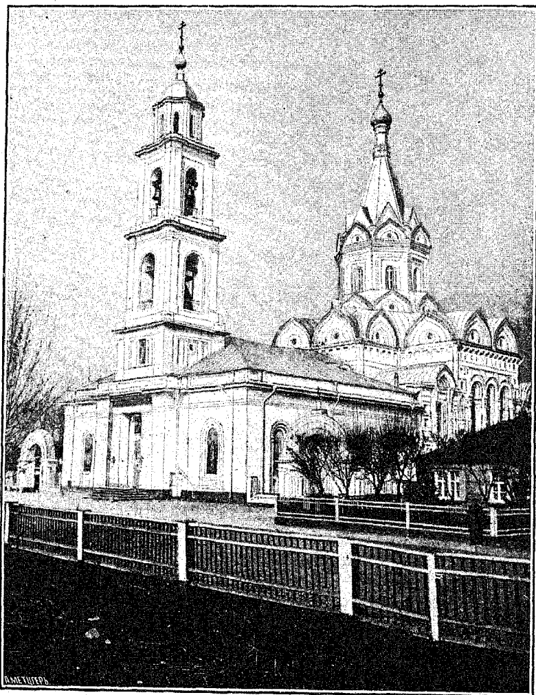
Главный фасадъ существующаго храма.
