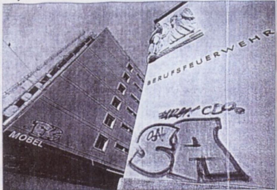
Graffiti an Häuserfassaden, hier an der Feuerwehrekaserne an der Viktoriastrasse, ärgern nicht nur die Hauseigentümer. (Bild: amoa)
